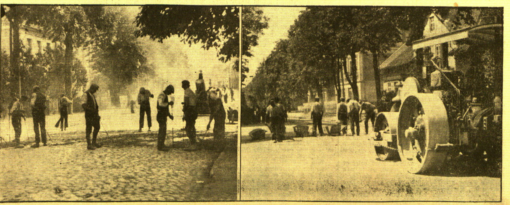
Asphaltpflasterarbeiten in Heydekrug
