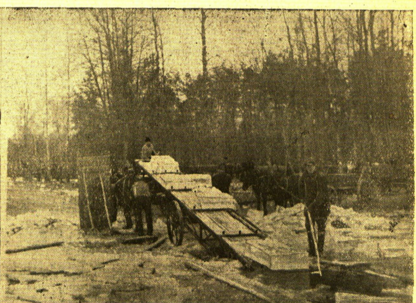
Rechts: Die Eisblöcke werden unter Benutzung eines Eiselevators auf einen Wagen emporgewunden
