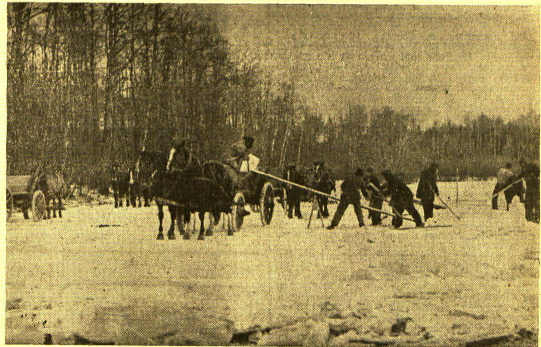
Wenn der Eiselevator gerade einmal streikt, werden die Blöcke auf einer Schlippe einzeln in den Wagen geschoben
