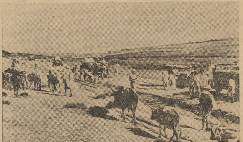
Budowa drogi w okolicach Harraru.
