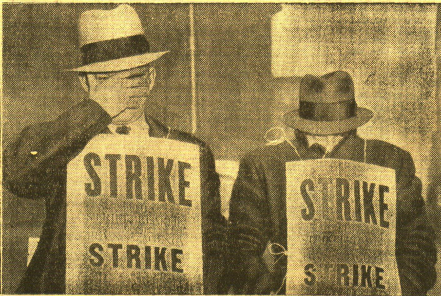
3000 Gebäude Newyorks ohne Fahrstuhlbetrieb
