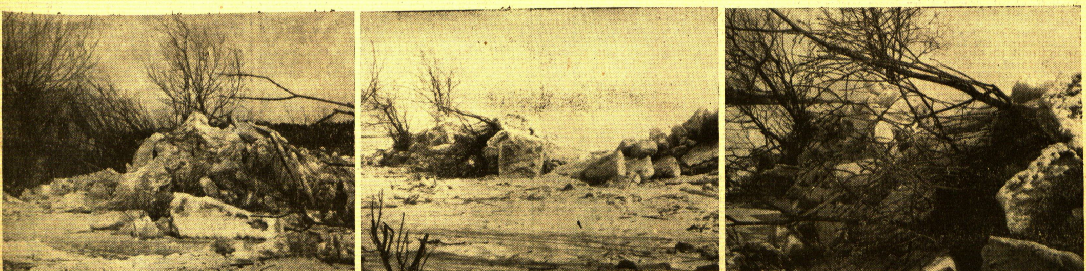
An den Uferbefestigungen in Nidden sind im Laufe der letzten Wochen durch Eispressungen schwere Schäden entstanden. Diese sind unso empfindlicher, als das Gassufer von Nidden überhaupt nur wenig geschädigt ist. Das Wasser des Gaffs und der Eisgang bedrohen in immer stärkerem Maße das Land und kommen den Wohnhäusern von Jahr zu Jahr näher. Die obenstehenden Aufnahmen geben eine Anschauung davon, mit welcher Wucht sich diesmal die Eisschollen auf das Land gedrängt und die als Schutz gedachten Bäume und Sträucher entwurzelt oder unter sich begraben haben.
