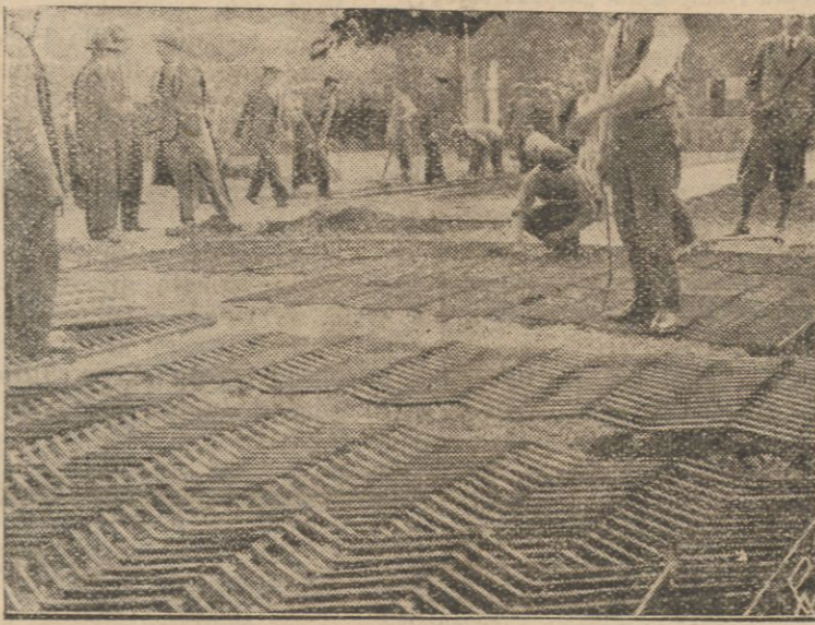
Na odcinku komunikacyjnym Katowice—Królewska Huta rozpoczęto budowę pierwszej na ziemiach polskich drogi stalowej. Zdjęcie nasze przedstawia roboty przy budowie tej drogi. Na pierwszym planie widać rozpoczętą na ziemi siatkę stalową.
