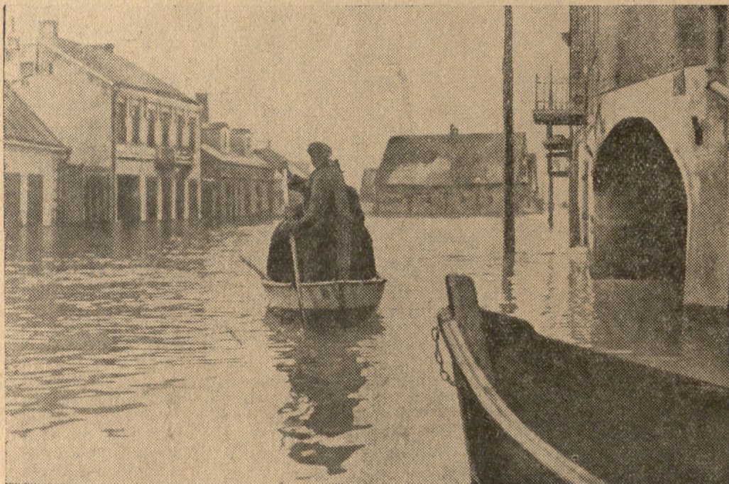
Jak już pisaliśmy, Niemen i Wilja wylały pod Kownem. Znaczna część miasta została zatopiona. W starym mieście woda pokryła fundamenty fabryk i domów do 2 1/2 metrów wysokości.
