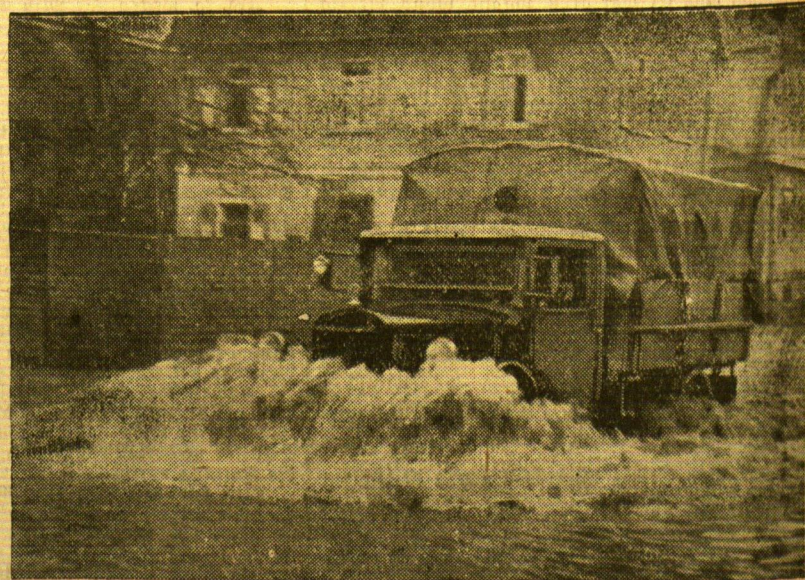
Uberschwemmung auch im Maingebiet
