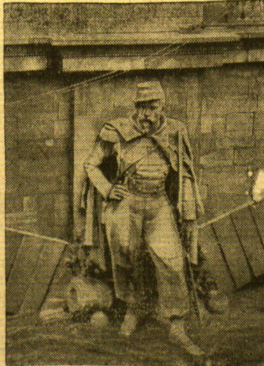
Der Zuaue an der Almatibrücke steht bereits im Wasser
