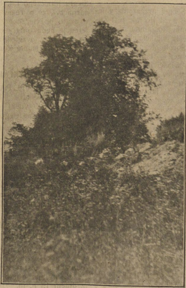
GRUZY FUNDAMENTÓW STAREGO DOMU MIESZKALNEGO W ZUŁOWIE.
