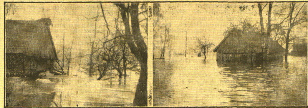
Zwei Bilder aus dem Heberschwemmnungsgebiet
