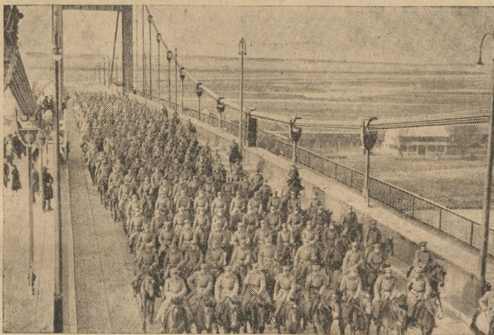
Po pięcioletniej budowie został w Belgradzie, wykończony jedyny nie tylko w południowej Jugostawji, ale i na całych Bałkanach, most łańcuchowy. 800 jeźdźców, na koniach przejechało most, by wypróbować jego nośność.
