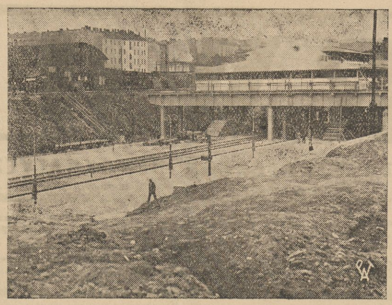
Widok na nowy tymczasowy dworzec średnicowy w Warszawie po burzeniu Archa- ologicznego go w Alei Jerolimskiej. Widoczne są podjazdy po obu stronach odkrytego tu- nelu oraz perony betonowe, na których sta- wiono już 4-ramienne wysokie latarnie elektryczne. Tory na tem miejscu są całkowi- cie wykończone.
