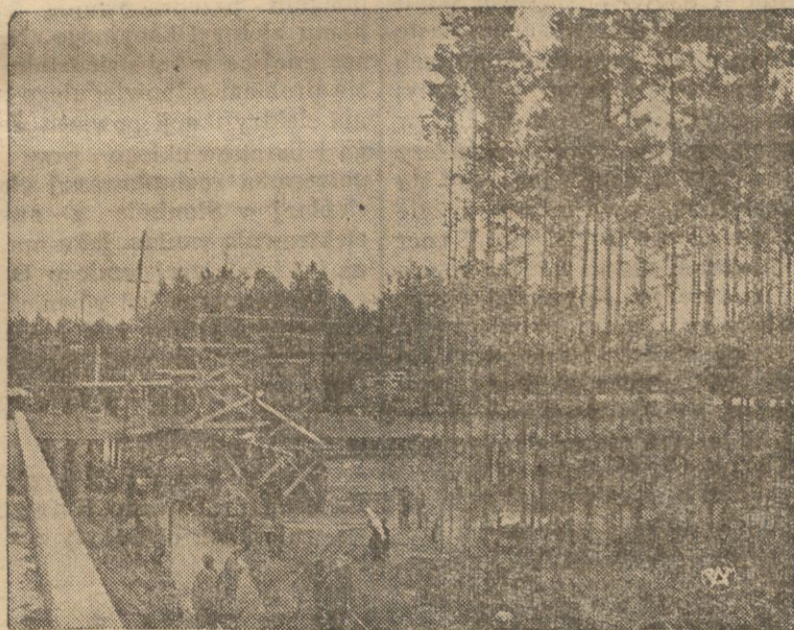
Budowa żelazo-betonowej hali fabrycznej w wysokopiennym lesie sosnowym.
