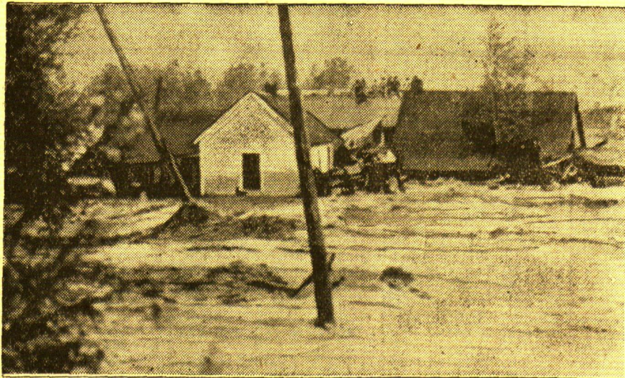
Flucht auf die Dächer vor der Wasserkatastrophe
