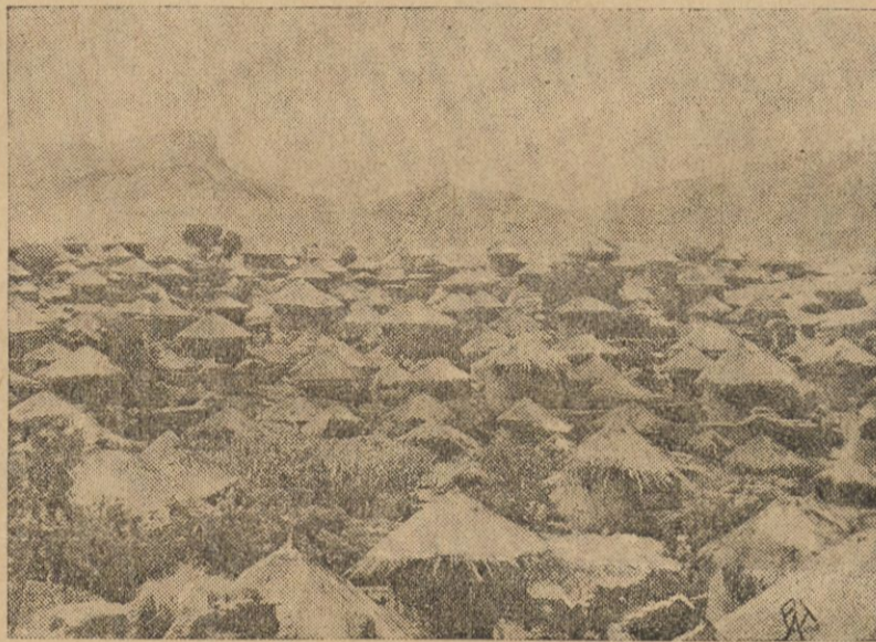
Architektura abisyńska nie ulega zbyt wielkiemu wpływowi europejskiemu, czego najlepszym dowodem jest przedstawiony na naszym zdjęciu kompleks domostw w Okata, głównym mieście prowincji Lasta, w północnej Abisynji.
