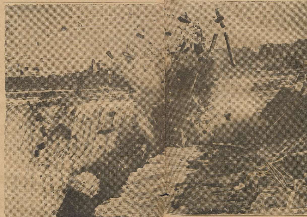
Rozsadanie skał na Niagarze. Wpobliżu wodospadu Niagara niedawno przy pomocy dynamitu rozsadzono część otaczających ten wodospad skał. Ilustracja przedstawia jedną z licznych eksplozji.
