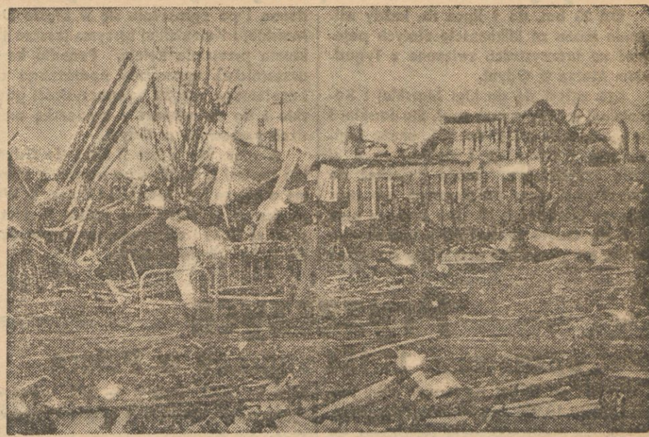
Fragment zniszczenia miasta Clyde w stanie Texas spowodowanego niszczycielskim, rozszalałym tornado, podczas którego szereg osób poniosło śmierć, zasypanych gruzami zburzonych domów.
