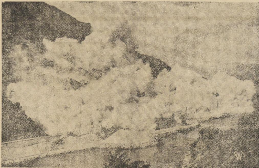
W miejscowości Bonawe (Szkocja) przy budowie jednej z nowych dróg musiano wysadzić w powietrze skałę granitową, objętości blisko milionton. Zdjęcie nasze przedstawia moment rozsadzania skały.
