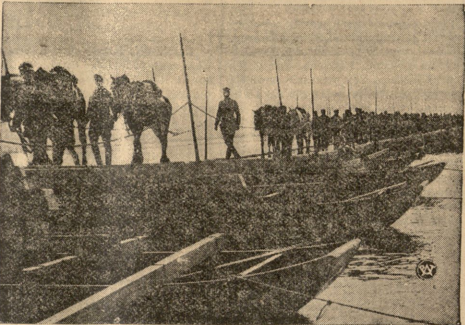
Przeprawa legionistów przez Wisłę na zbudowanych przez nich pontonach, pod Rachowem (r. 1915).
