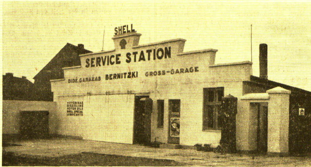
Die Frontansicht der Garage mit den Tankstellen
