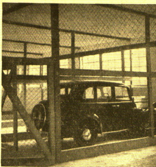
Blick in das Innere der Garage
