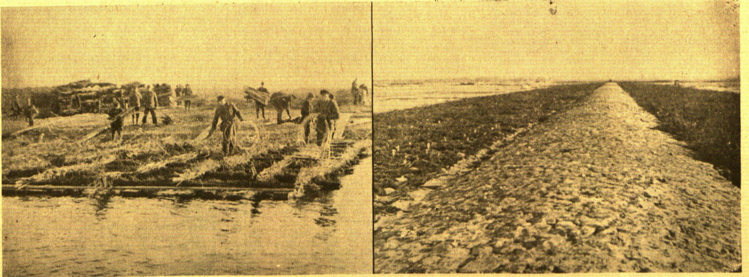
Der Bau der neuen Mole an der Skirwiethmündung. Links: Zur Befestigung des Molenkörpers unter Wasser gegen Auskolkungen und Beschädigungen werden sogenannte „Klappen“ hergestellt, wie es das Bild zeigt. Die Verstellung erfolgt durch kreuzweises Verbinden von Wurfkastchinen. Die Arbeit geschieht auf einem Floß. Nach Fertigstellung einer solchen Klappe werden aus derselben die Balken des Floßes entfernt, das ganze mit Steinen bepackt und an der vorgeschriebenen Stelle der Biegung verankert, so daß die Klappe gleich einer Matte die Biegung unter Wasser bedeckt. Rechts: Ein Teil der in diesem Jahre fertiggestellten Mole.
