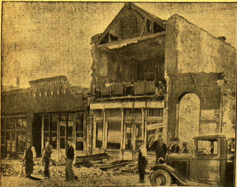
Von der schweren Erdbebenkatastrophe im nördlichen Helena (USA)
