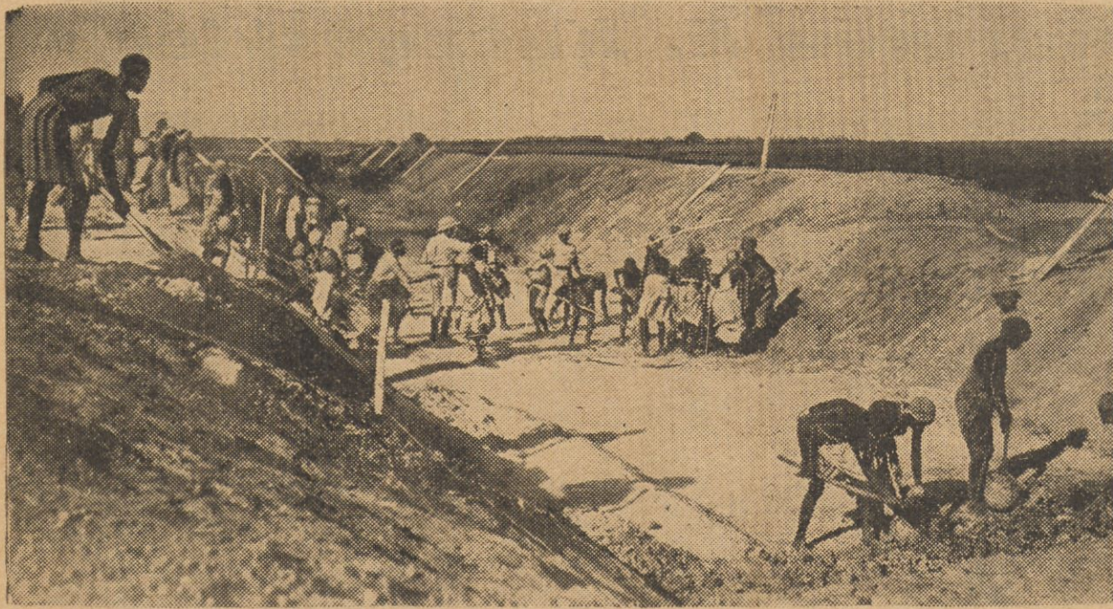
Abisynja przygotowuje się do wojny. Abisyńczycy zamierzają w czasie wojny z Włochami znieść tamy i wypuścić rzeki w płaskie pustynie. Na zdjęciu widzimy robotników przy budowie kanału strategicznego na granicy włoskiej.
