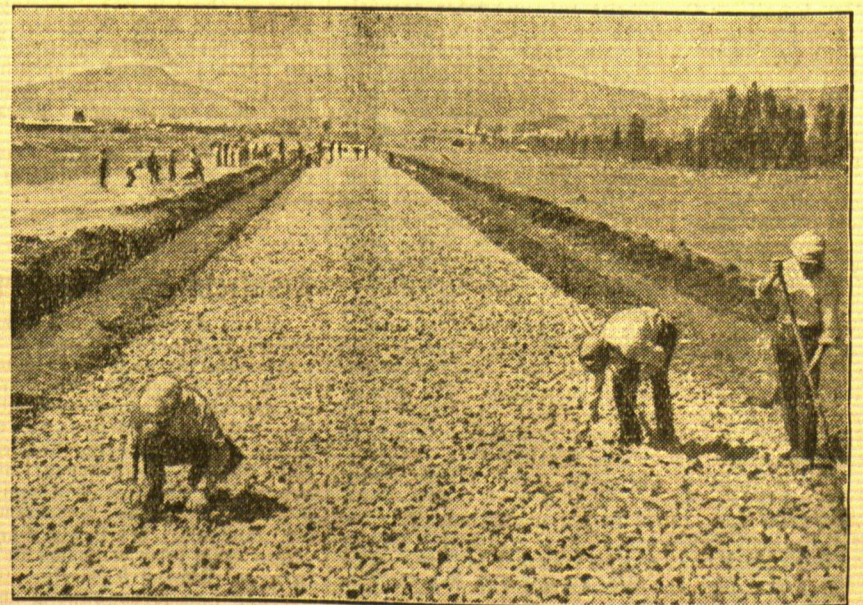
Kolonisationsarbeit der Italiener in Abessinien. Unter den verschiedenen Straßen, die im eroberten Westjopien von den Italienern erbaut werden, geht die nach Gimma ihrer Fertigstellung entgegen.
