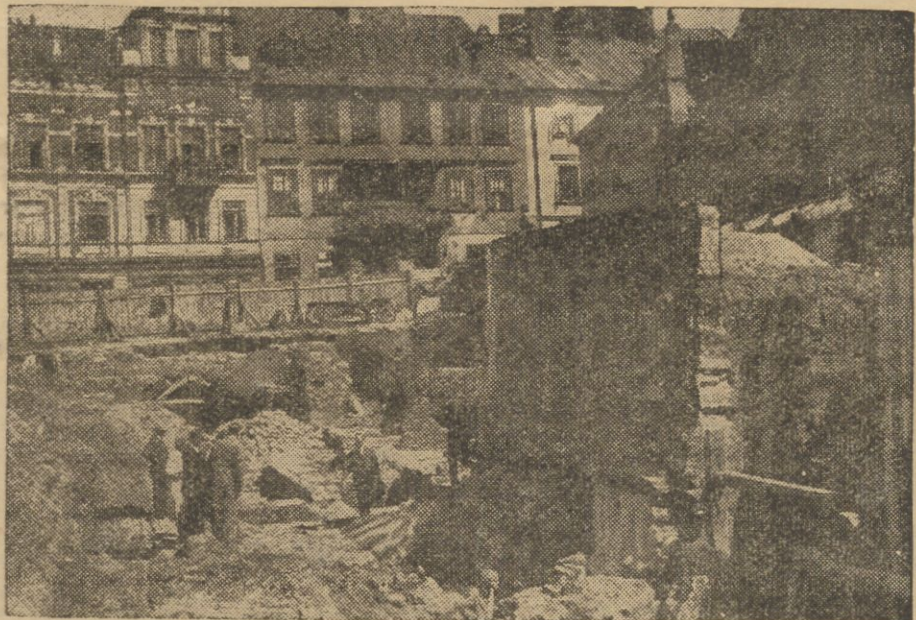
Wśród licznych prac prowadzonych przez Zarząd Miejski m. st. Warszawy, osobne miejsce zajmują prace nad odsłonięciem murów obronnych starej Warszawy. Na zdjęciu widać już zupełnie dobrze odsłoniętą basztę t. zw. Prochową.
