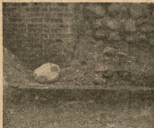
Belka stropowa (?) pozostawiona na miejscu wewnątrz.
