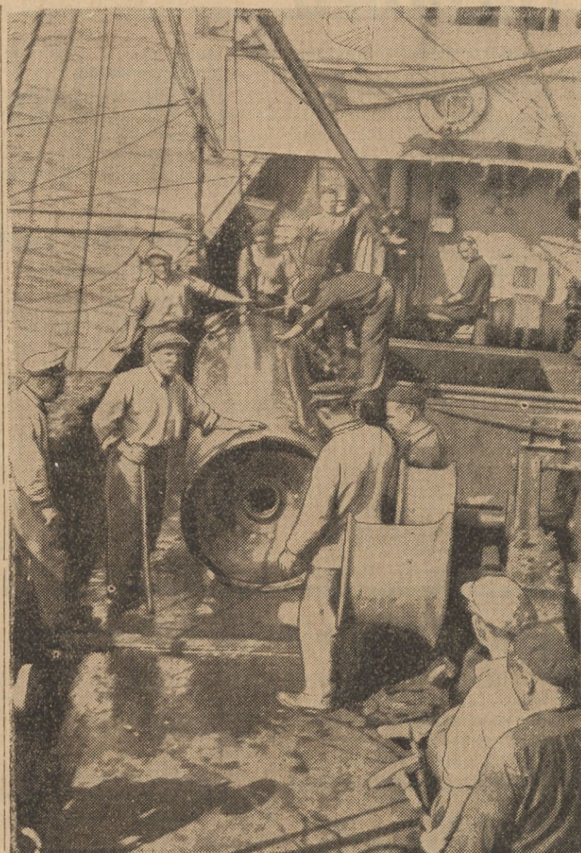
Włoski parowiec „Artiglio” z wydobytem w ostatnich dwu latach z pokładu zatopionego w 1922 okrętu „Egipt” złotem wart. 1.800.000 funt. szterl. w drodze do Plymouth, dokąd zawiozł ładunek. Cylinder na ilustracji jest częścią potężnego aparatu ssącego, który został specjalnie skonstruowany dla wydobywania złota z pokładu „Egiptu”.
