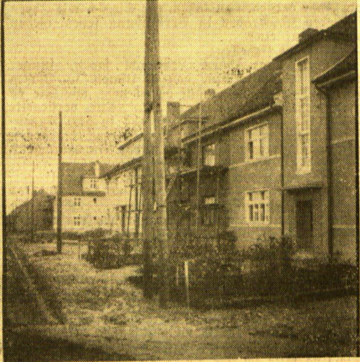
Rechts: Neubauten in der Sandwehrstraße, zum Teil noch mit den Baugerüsten.
