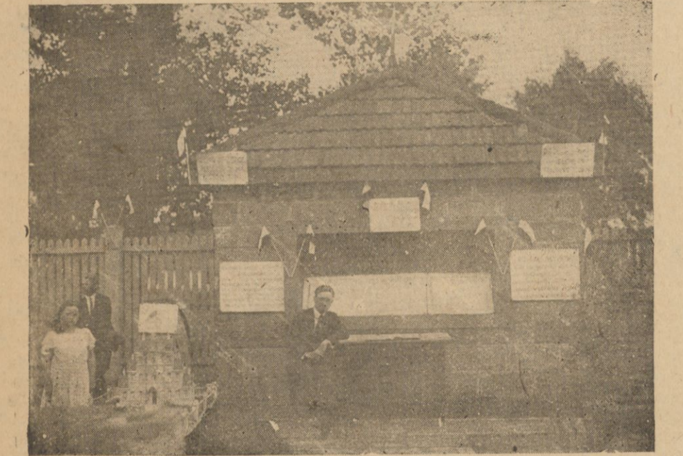
Pawilon na wystawie w Mołodecznie z dn. 22-IV 1930 r. wykonany przez sejmikową betoniarnię z pustaków i dachówki cementowej.
