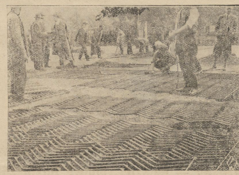
Na odcinku komunikacyjnym Katowice — Królewska Huta rozpoczęto budowę pierwszej na ziemiach polskich drogi stalowej. Zdjęcie na szcze przedstawia roboty przy budowie tej drogi. Na pierwszym planie widać rozpoczętą namiem siłą siatkę stalową.
