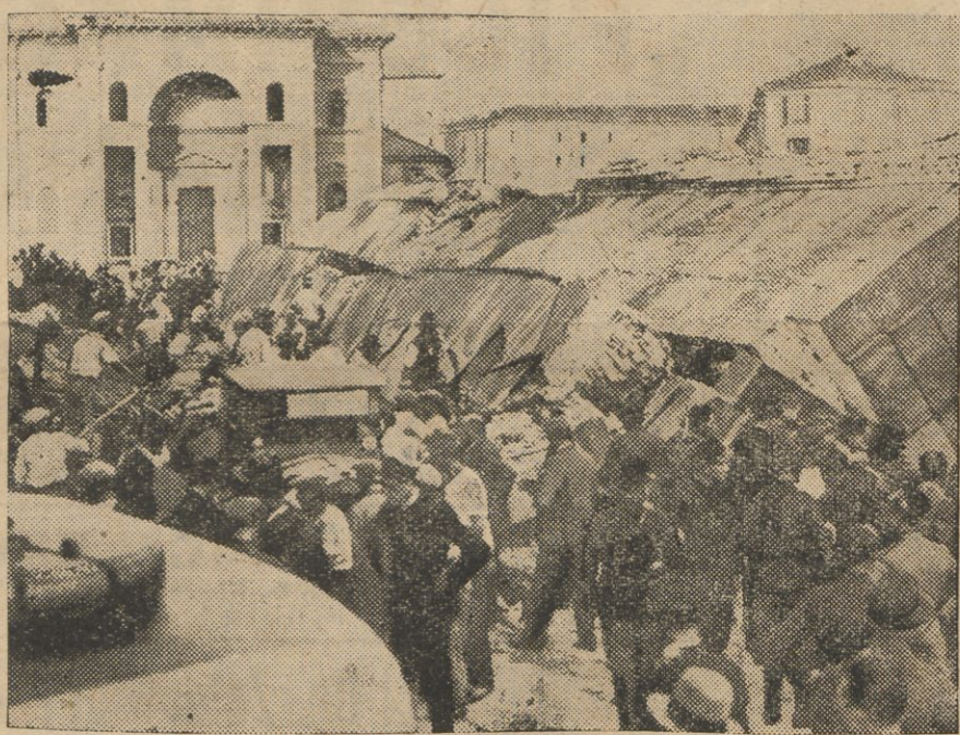
W Medjolanie w czasie robót runął wiadukt, budowany na dworcu, grzebiąc pod sobą i raniąc wiele osób.
