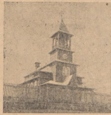
Ółok murów zamku wnoszą się nowo-wybudowane drewniany kościół kat. w ciekawej architekturze.
