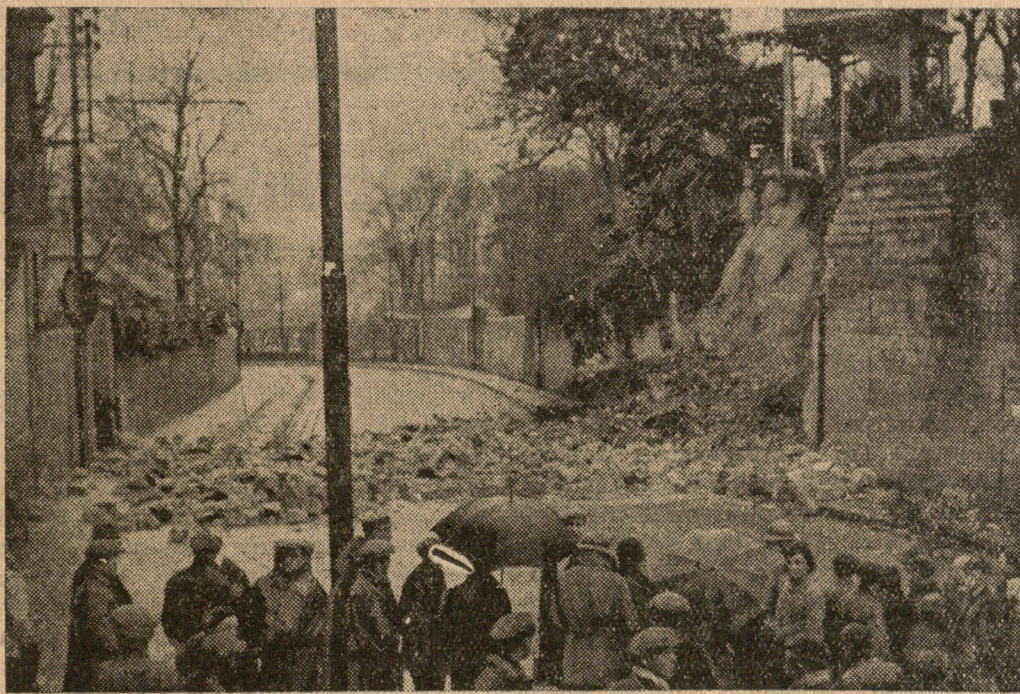
Podczas silnego huraganu, który ostatnio szalał nad Paryżem, przy drodze z Wersalu do Le Pecq runął jeden z domów, grzebiąc pod gruzami 5 ludzi. Na zdjęciu — widok zniszczonego domu nazajutrz po katastrofie.
