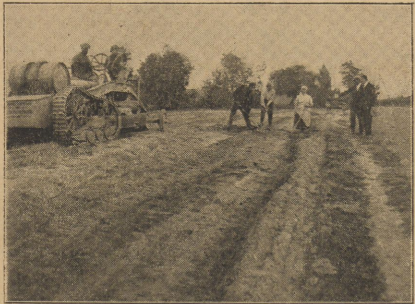
Pogłębiarka Bitvargen na odcinku Rudomino-Turgiele.
