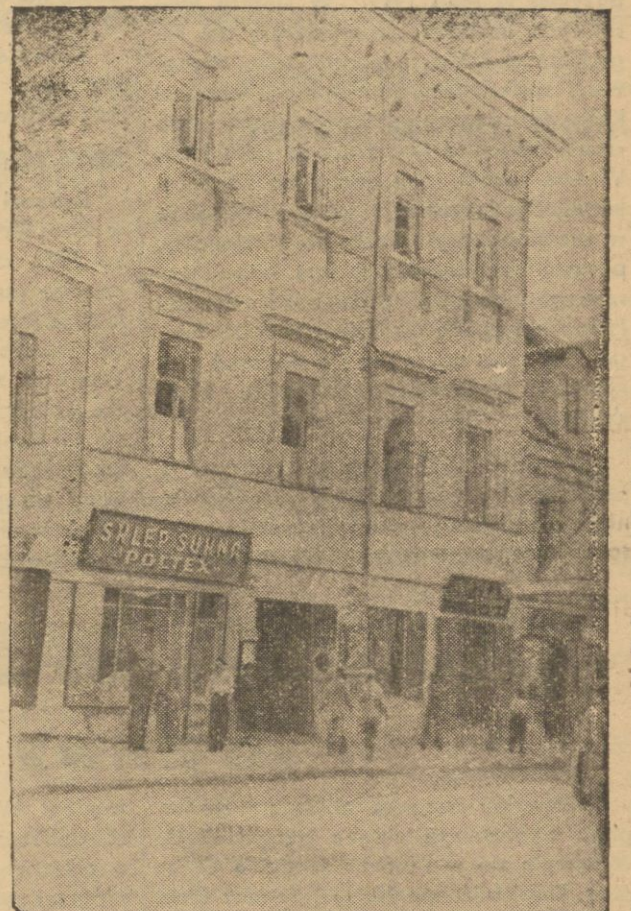
1. Dom klasztoru SS. Wilczynek przy ul. Niemieckiej 15.
