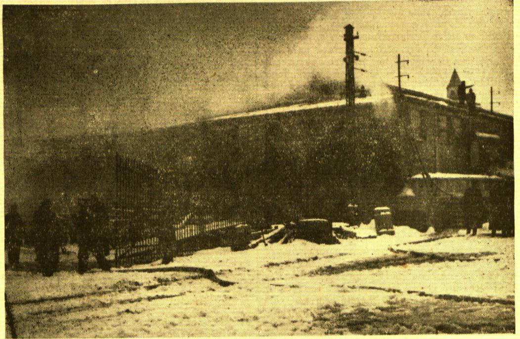
Der Zollspeicher brennt! Unsere Aufnahme wurde während der Löscharbeiten der Feuerwehr bei dem Brand im Zollschuppen am Pachhof II gemacht. Man sieht die starken Rauchwolken, die von den schwelenden Baumwollballen hervorgerufen, aus dem Dach hervordringen.
