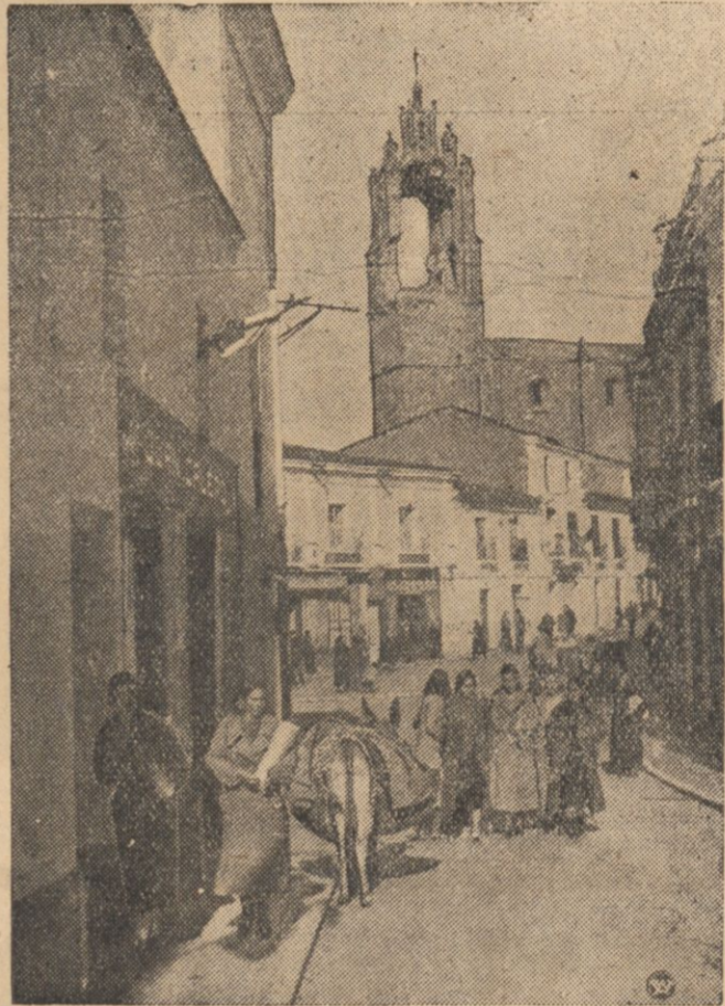
Reprodukujemy fragment z hiszpańskiego miasta Almdendralejo, zajętego ostatnio przez wojska powstańcze armii gen. Franco. Na pierwszym planie widoczna jest wysoka wieża kościoła, doszczętnie zniszczona wskutek działań wojennych. Grupy pozostałych przy życiu mieszkańców starają się przywrócić miasteczku dawny, ruchliwy wyraz. Jakże ponuro i pęsepnie przedstawiają się ci ludzie na tle obróconych w gruz szych świątyń i domów.
