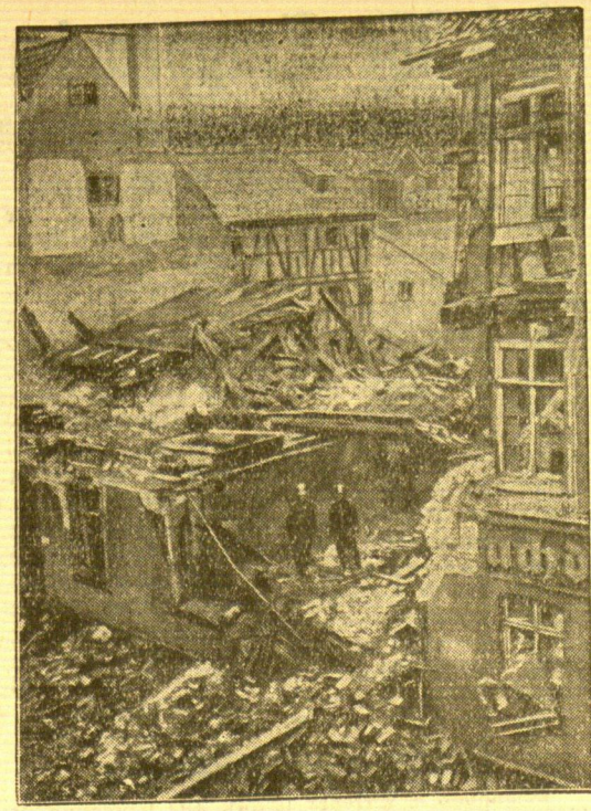
Hauseinsturz in Jüterburg Auf bisher noch völlig ungeklärte Weise kam es in einem Haus in Jüterburg zu einer Explosion. Da gegenwärtig Erneuerungsarbeiten in diesem Hause durchgeführt wurden und die Hausbewohner ausquartiert waren, sind glücklicherweise nur sieben Verletzte zu beklagen. Unser Bild zeigt die Unglücksstätte.
