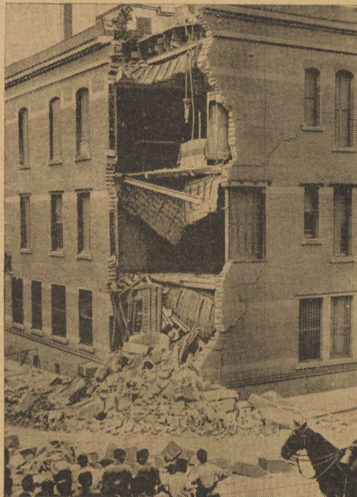
Zamach bombowy w Barcelonie. Nieznani sprawcy rzucili bombę w magazyn tramwajów miejskich w Barcelonie. Wskutek wybuchu uszkodzony został cały narożnik domu od dachu aż po piwnicę.
