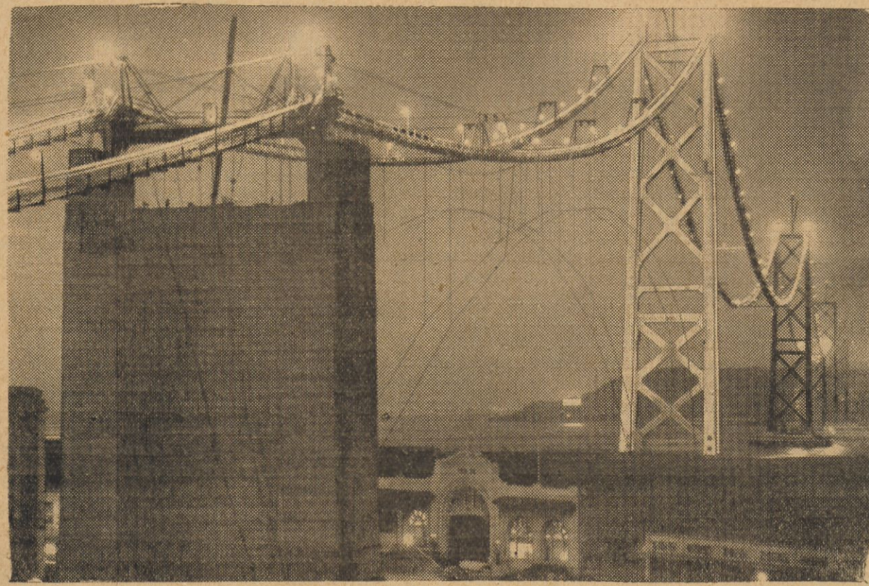
Największy most na świecie. Nocne zdjęcie największego na świecie mostu między San Francisco i Oakland. Na moście wmontowuje się obecnie łożyska do kabli, które będą most podtrzymywały. Praca odbywa się dniami i nocą. W nocy z tego powodu most jest rzęsiście oświetlony.
