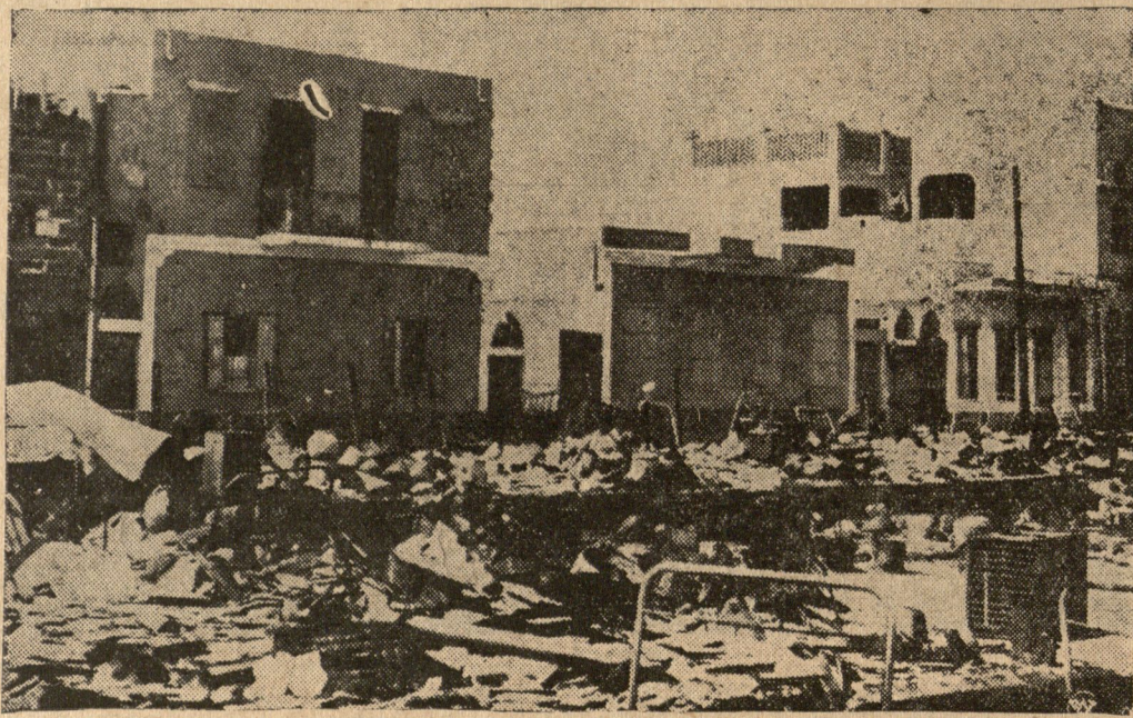
Zdjęcie nasze przedstawia fragment zniszczenia Jaffy po krwawych zaburzeniach arabsko-żydowskich. Na zdjęciu widoczny zburzony szpital żydowski.
