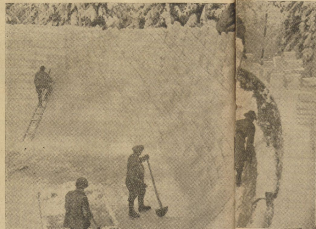
Wykładanie taflami lodowymi toru saneczkowego w Berlinie.
